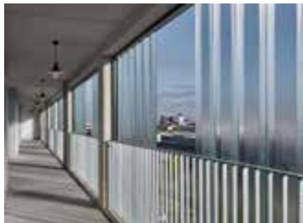
Die kompakten, durchgesteckten Wohnungen orientieren ihre Wohnräume mit Loggien zum Wasser, die Schlafräume zu den halbprivaten Laubengangbereichen. Die Laubengangfassade besteht aus Industrieglas und gewährleistet sowohl Schallschutz als auch Belichtung und Belüftung.
