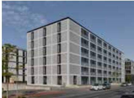
Der Baukörper greift Elemente industrieller Hafenarchitektur auf und verweist damit auf den Ort und seine Transformation. Die Fassade deutet ein Tragwerk an und wird abhängig von den dahinterliegenden Nutzungen unterschiedlich ausgefacht. Die Erschließung der Wohnungen erfolgt über einen durch Treppe, Aufzug und Abstellräume gegliederten Laubengang.
